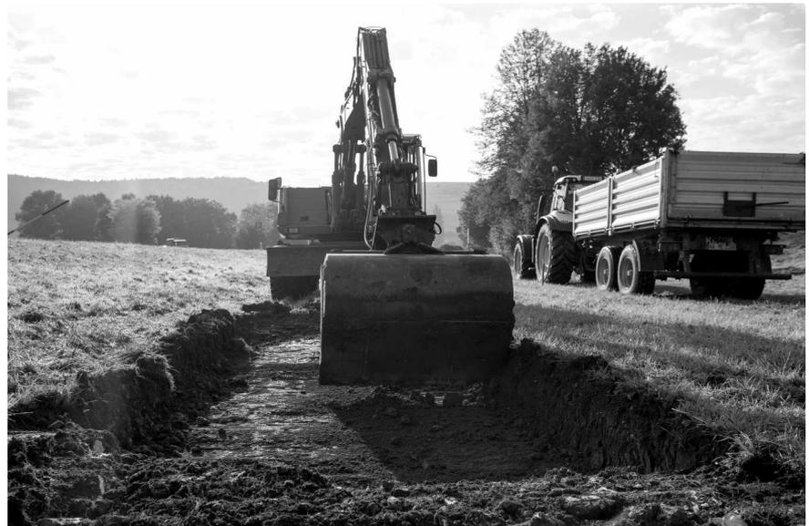
erledigen. Dann ging es an die Herstellung des restlichen Planums. Nach den notwendigen Vermessungsarbeiten wurde der Bahndamm neu hergestellt. Bis zu 70 cm tief musste der Humus ausgekoffert werden. Danach wurde der Damm mit Geotextil zur Schichttrennung, ca. 80 Tonnen Schroppen und 400 Tonnen Kalk-Frostschutz-Tragschicht-Material hergestellt. In gleicher Weise wurde auch das Planum für das künftige Abstellgleis hergestellt.
