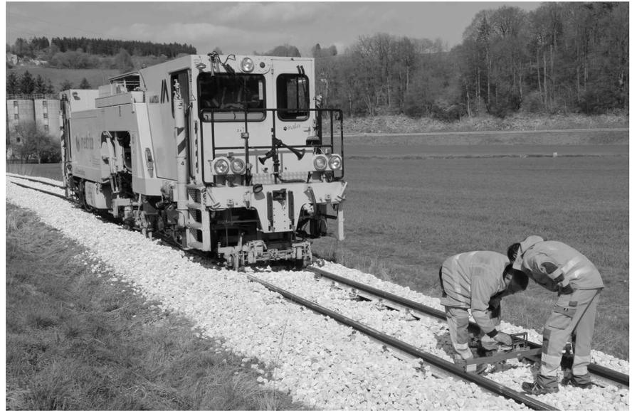
**Oben: Penibel wird am 20. April 2017 bei Iggenhausen kontrolliert, ob „Balu“ die Gleislage korrekt hergestellt hat.**
