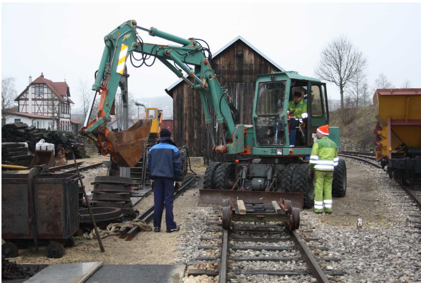
Unten: Als äußerst nützlich erweist sich der gebraucht beschaffte Atlas-Bagger 1104. Im Frühjahr kam er erstmals bei der Erneuerung des Gleises zur Lokremise zum Einsatz. Foto: Ingo Adam
