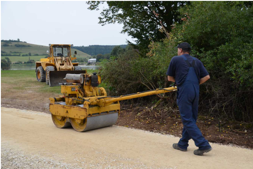
Oben: Seit Ende September ist das Planum der Neubaustrecke entlang des Härtsfeldsees wieder hergestellt. Foto: Jürgen Ranger
