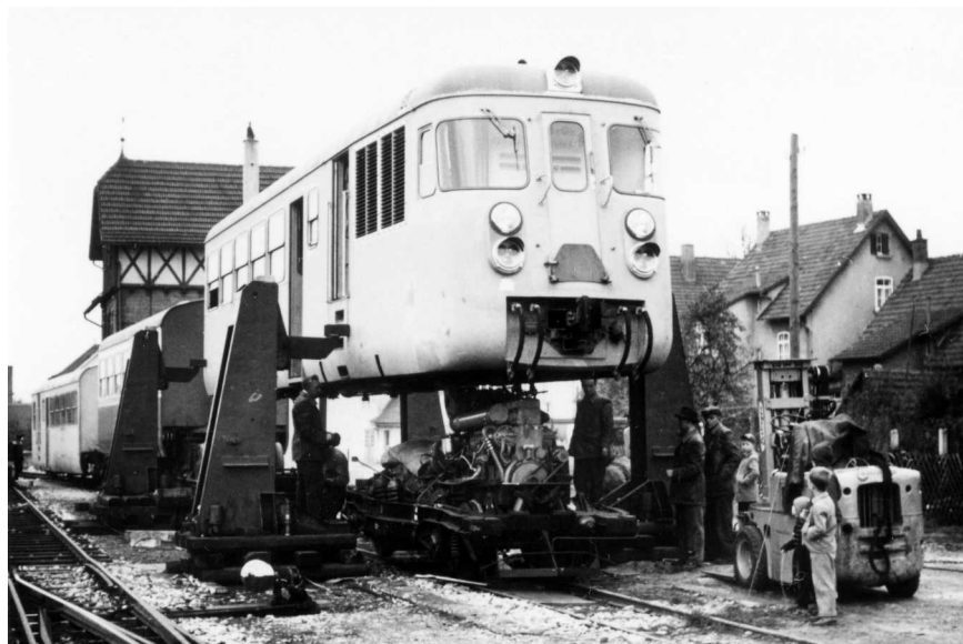
Unten: Montage des Triebwagens für die Peloponnes-Bahn im Oktober 1958 in Aalen Gbf. (Sammlung Dietmar Schweizer),
