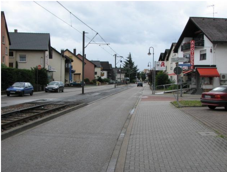
Abbildung 5-13: Beispiel Rheinstetten - Bahn in Mittellage, abschnittsweise überfahrbar
